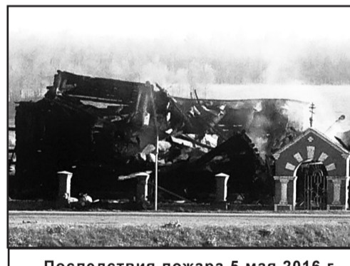
Последствия пожара 5 мая 2016 г.
